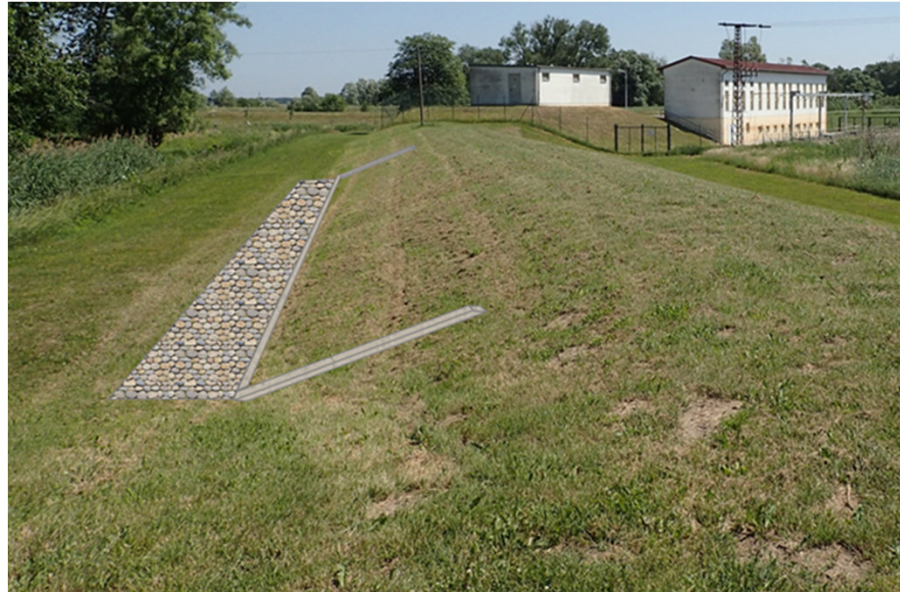
Normalzustand (mit regulärem Deichaufbau verfüllt)
